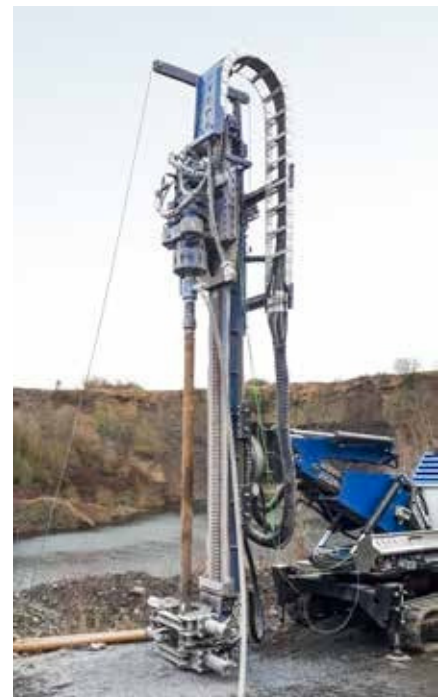
Bohrarbeiten in einem Basaltsteinbruch
